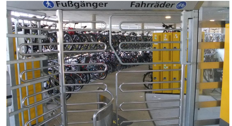
überdacht und abschließbar
