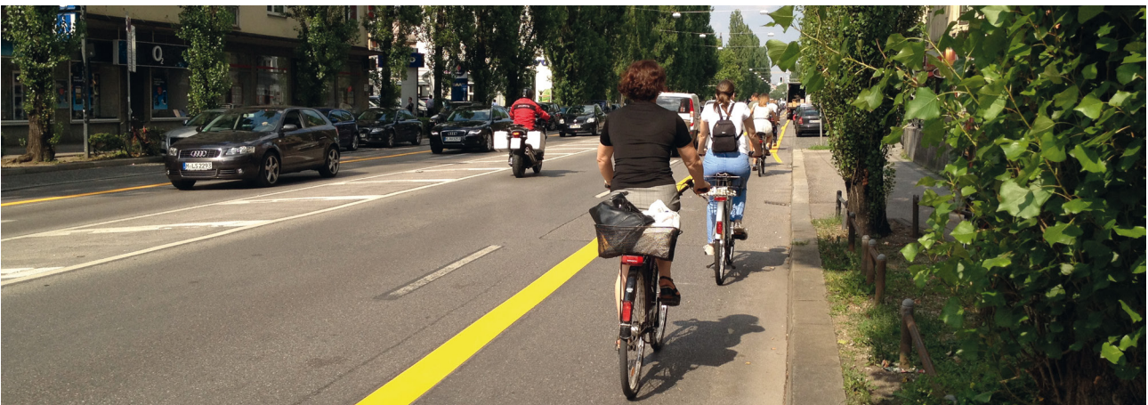
Bild 22 | Radfahrstreifen mit vorübergehend gültiger Fahrbahnmarkierung
