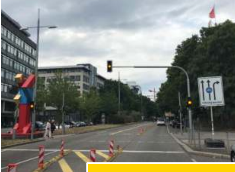
Provisorische Beschilderung Absperrung mit Minibaken
