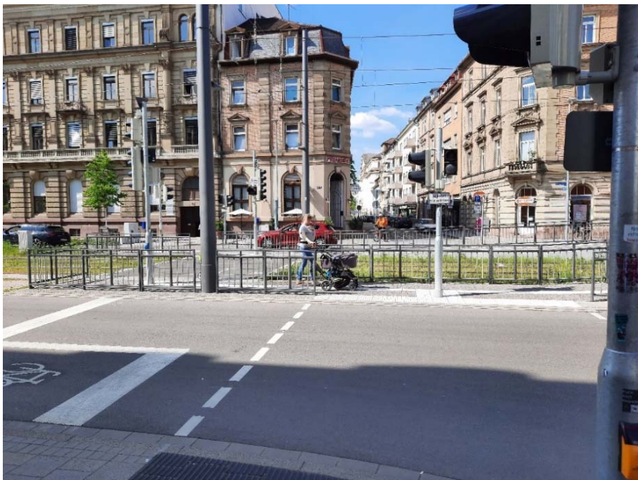
Querung Adlerstraße: wurde mit der Kombilösung neu geschaffen. Früher war das Queren der Straße nicht möglich.
